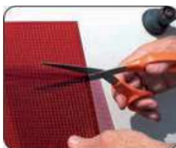
2. Cortar el panel de reparación
